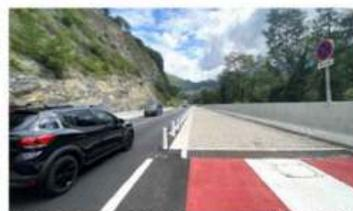
L'aire de freinage (voie de détresse, avec gravier), au bas de la rampe, a nécessité des travaux de terrassement de la falaise, pour créer l'emprise d'une nouvelle voie. Photo Le DL/ILC
